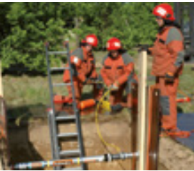
- работа в котловане, траншее
